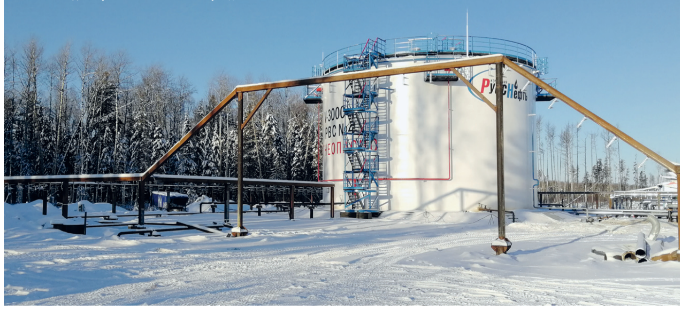
Новый РВС на ДНС Верхне-Шапшинского месторождения.
